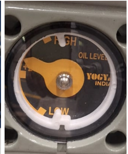
INDICADOR DEL NIVEL DE LIQUIDOS AISLANTE
